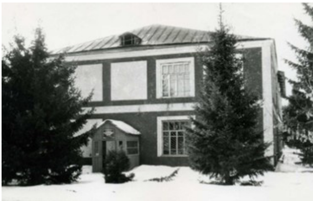
Здание районной библиотеки
