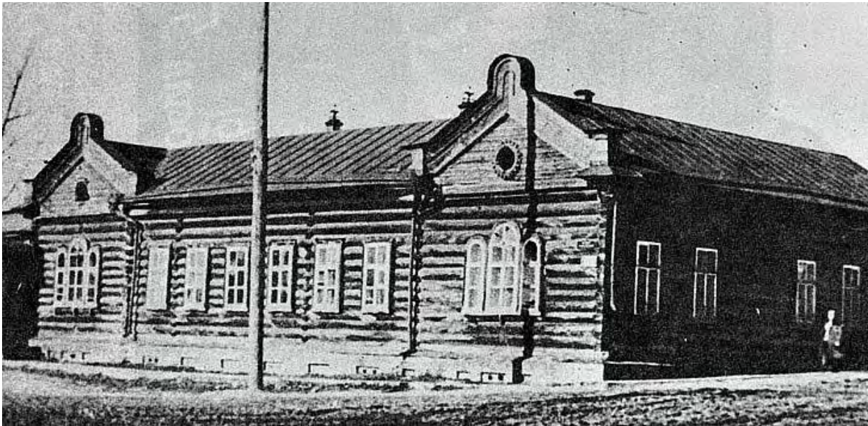
Дом Штильке в городе Барнауле.
