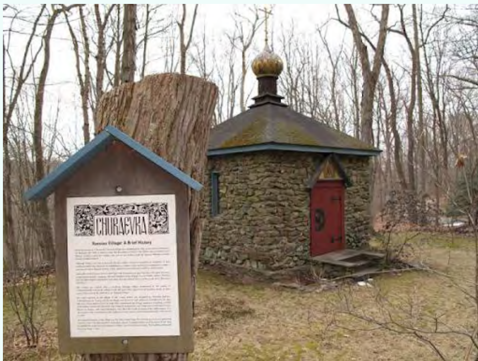
Часовня Святого Сергия Радонежского в Чураевке (штат Коннектикут, США). Построена по проекту Н. К.Рериха (современный вид).
