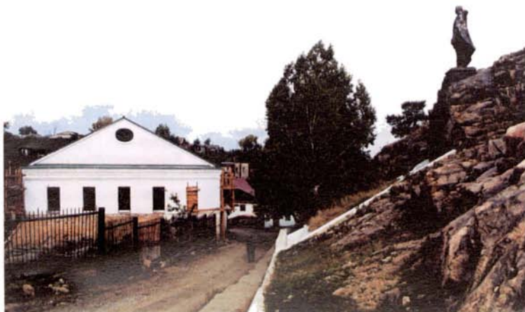
Здание Кольванской шлифовальной фабрики, построенное в 1802 г. унтер-шихтмейстером Ф.В. Стрижковым. Современный въезд на завод
